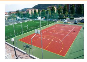
En correspondencia de las juntas, con el tiempo, pueden ocurrir microgrietas debido a los movimientos del soporte subyacente que no afectan la funcionalidad del sistema. Es recomendable hacer las juntas de dilatación cerca de la demarcación de las líneas de juego para hacerlas menos visibles y tener un mejor efecto estético.
